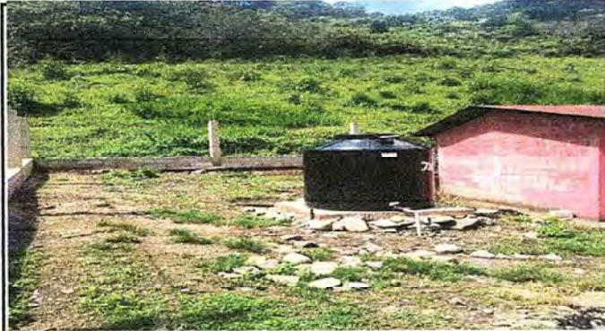
Foto 1: INSTALACION DE TINACO
