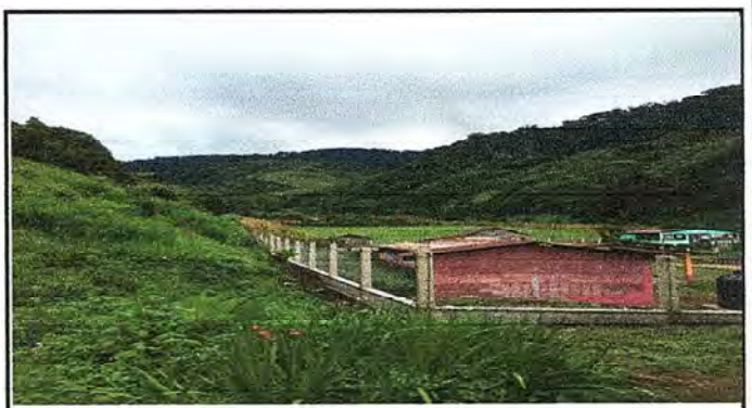
Foto 4: MURO PERIMETRAL TERMINADO
