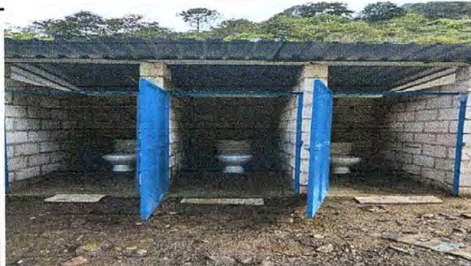
Foto 3: SUSTITUCION LETRINAS, PUERTAS, COSTANERAS Y PARED
