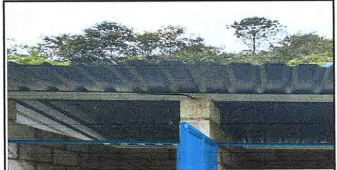
Foto 6: SUSTITUCION DE LÁMINA
